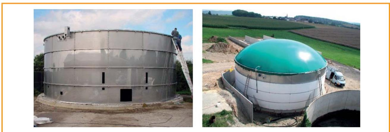
Figure 3.30: A special-steel digester under construction [Anlagen- und Apparatebau Lüthe GmbH]
