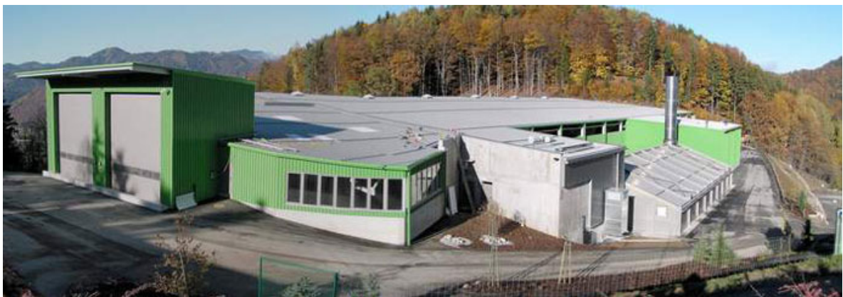
MBA Frohnleiten, Source: Servus Abfall
