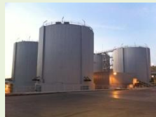
(Imagem:Greenlane Biogas GmbH)
