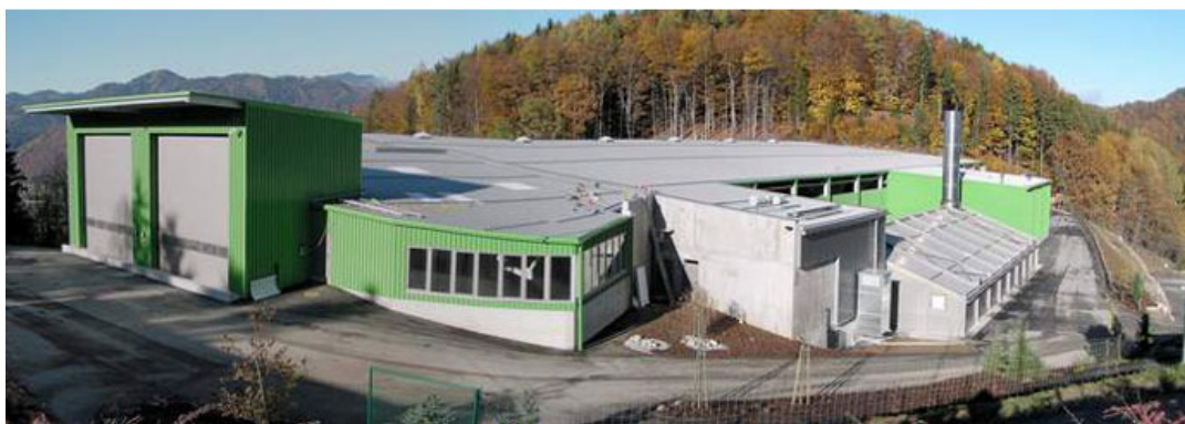
MBA Frohnleiten, Source: Servus Abfall
